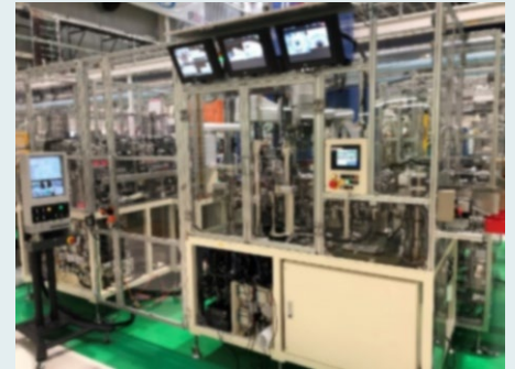
成形～検査～梱包自動ライン設備
